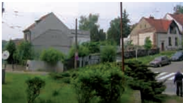
Současný neutěšený stav rohu Rybnické a Lesní je zapříčiněn nesvárem mezi soukromými vlastníky pozemku a objektu. V roce 2002 bylo nutno část objektu demolovat rozhodnutím stavebního úřadu MČ z důvodu havarijního stavu.
