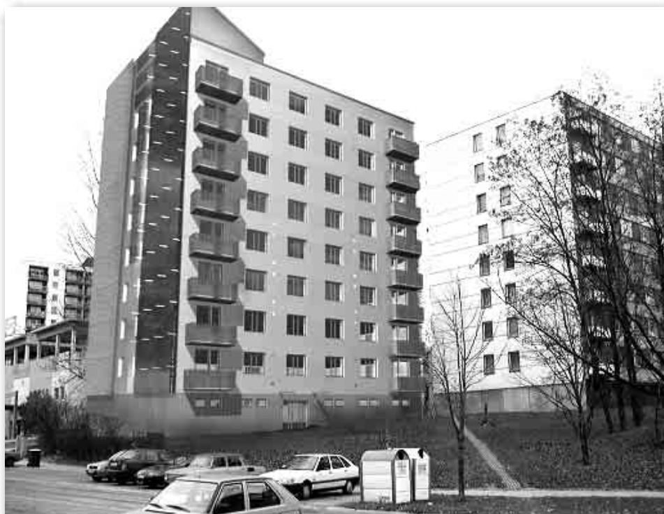
Takhle bude vypadat dům Oblá 14 po rekonstrukci. Na jižní fasádě budou umístěny dva solární kolektory.
